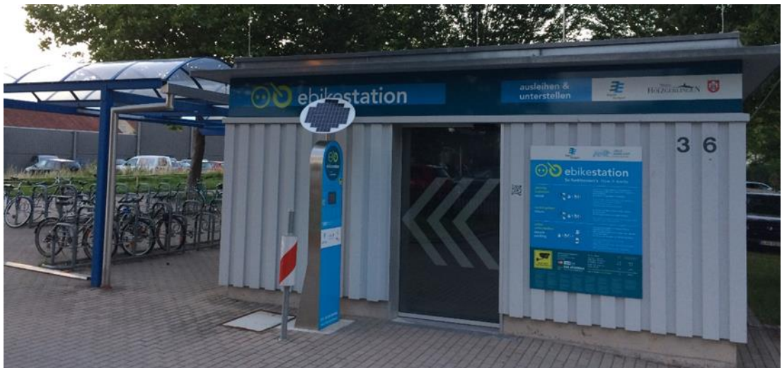
Abbildung 44: E-Bikestation Region Stuttgart am Bahnhof Holzgerlingen (eigene Aufnahme)
