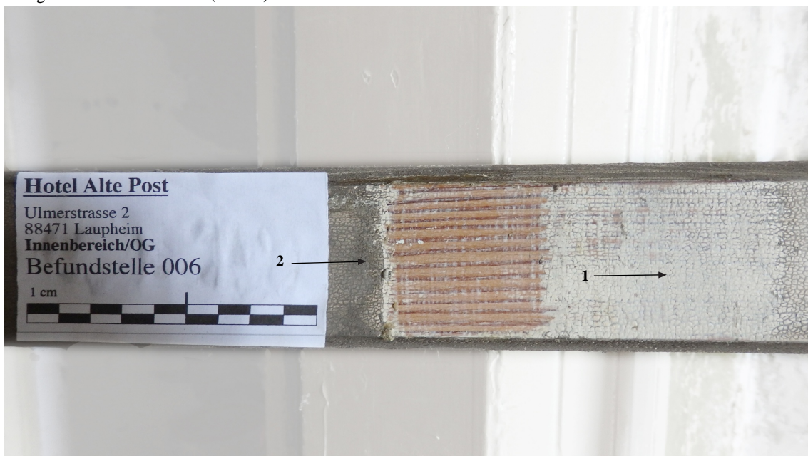
II Bef 006 Großer u. Kleiner Saal Winterfenster 1. Fassung Gebrochener Weisston 2. Fassung grünliches Grau
