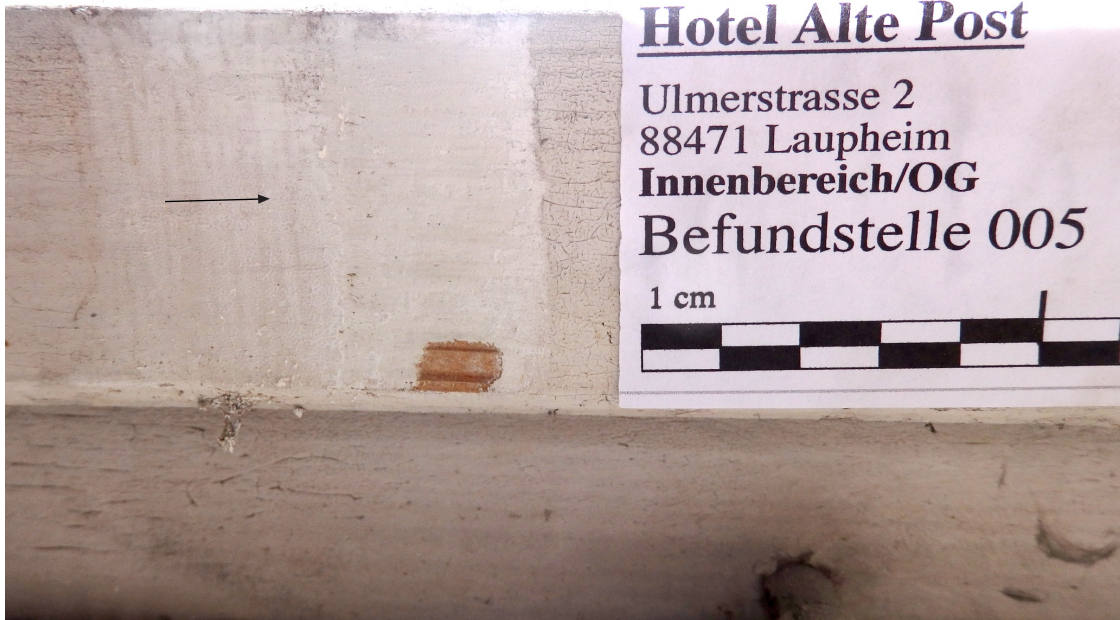
I Bef 005 Treppenhaus z. DG Fenster, Originalton: Gebr. Weisston (s. Pfeil)
