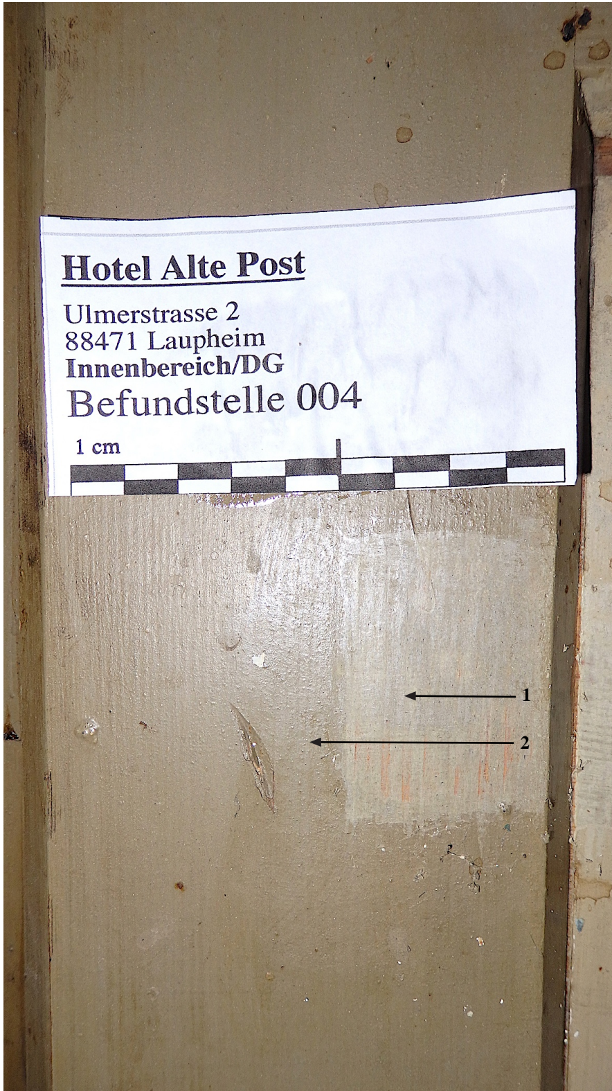
I Bef 004 Raum 3.01 Tür z. Kammer Farbfassungen: 1 Heller Grauton 2 Leinölauftrag
